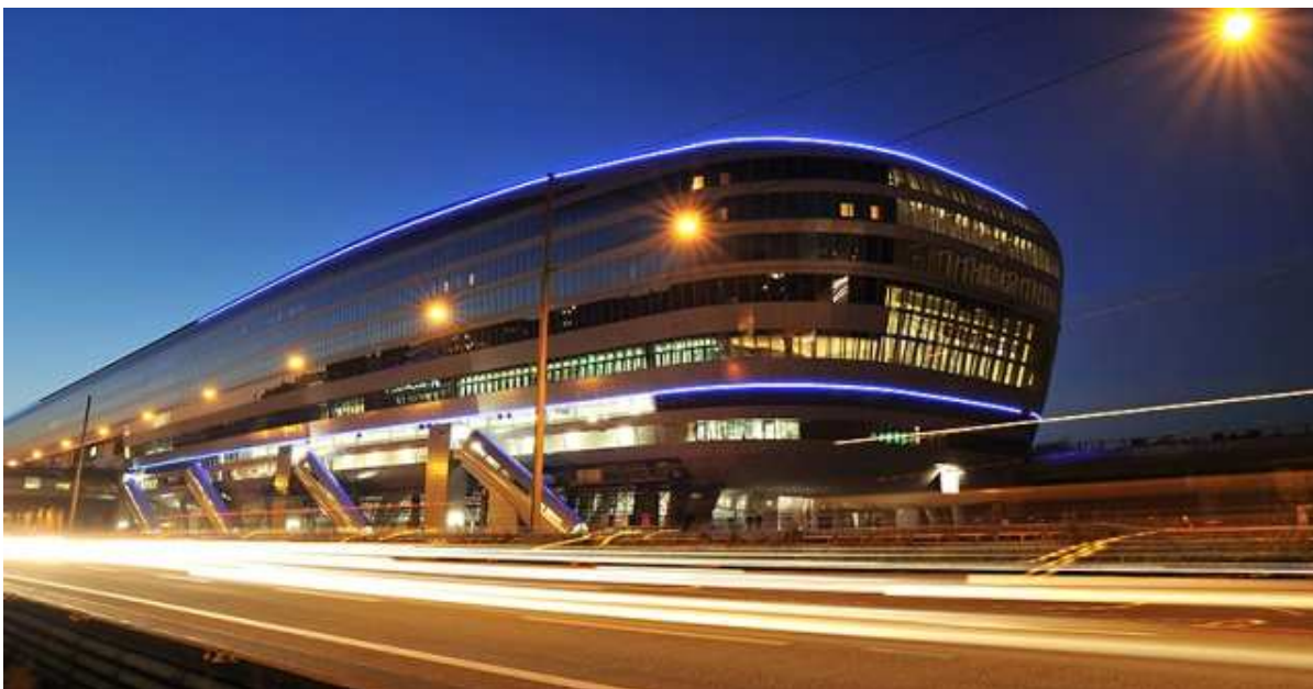
Bauobjekt „The Squaire“ am Frank- furter Flughafen
